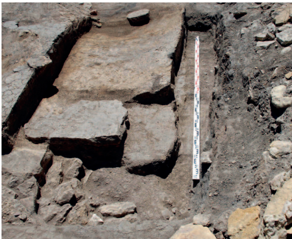
Рис. 91. Траншея под фундамент стены 11 помещения D, вид с севера
