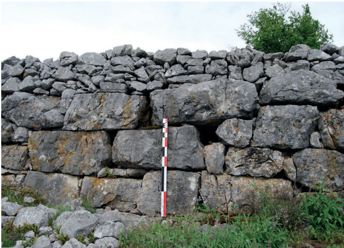
Fig. 15. Hellenistic wall at Mokseti (photo S. Shpuza)
